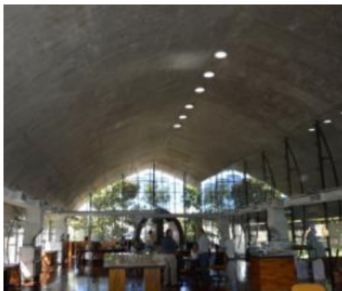
Figura 3 – Técnica de lâmpadas solares
